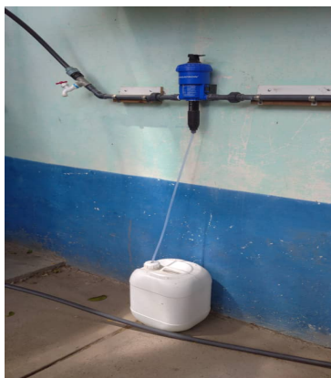
Dosificador de cloro y pruebas de concentración de cloro libre
